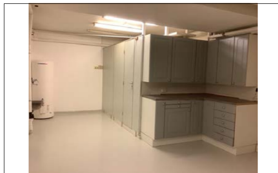
Kjellerrom med liten innredning under butikklokale.
